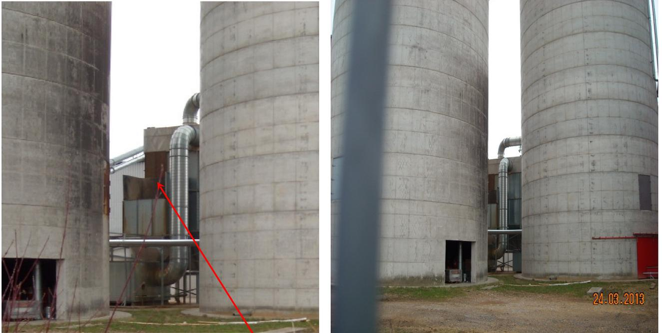
Auf dem Bild links ist zu erkennen, dass der obere Teil der Filter-Ausblasöffnung fehlt.
